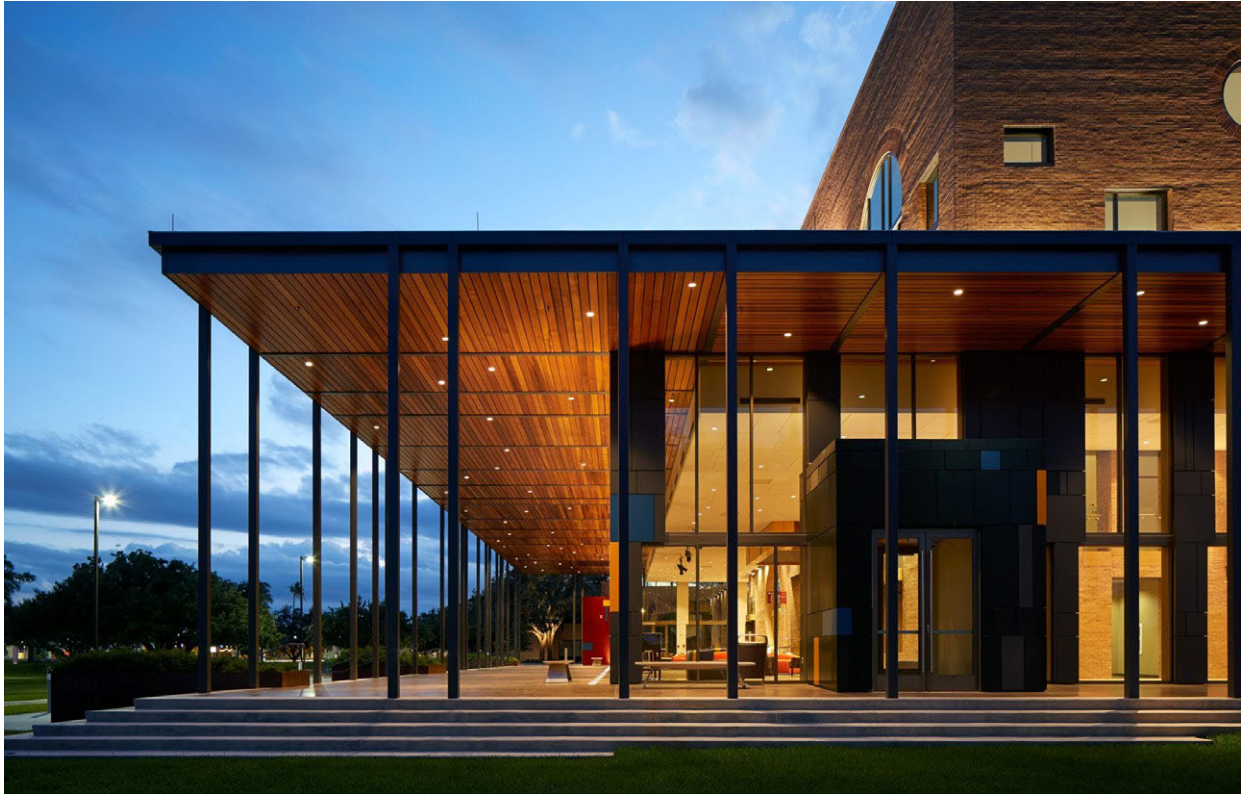
EPACA Entry Loggia
